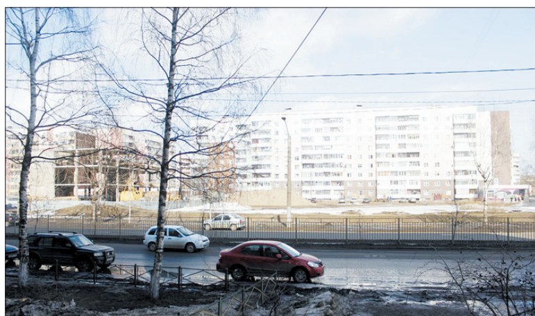
Территория, прилегающая к домам № 15, корпус 2 и №64 по проспекту Машиностроителей.
