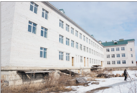
Здание недостроенной школы.
