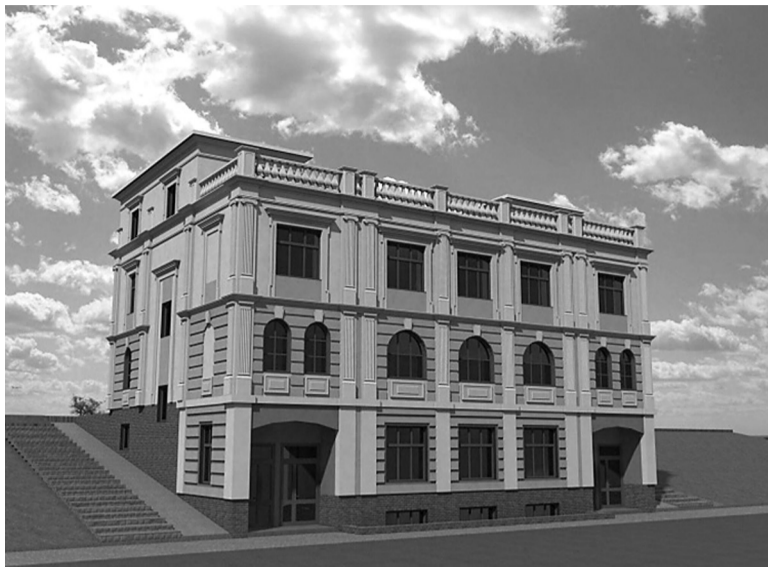
Так будет выглядеть «Сталин-центр», строительство которого началось в г. Бор Нижегородской области. (фото из открытых источников)
